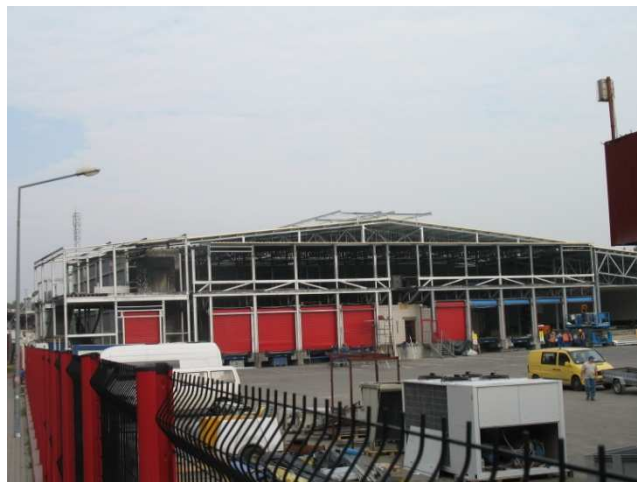
15.09.2009 r. – Główne elementy nowej hali produkcyjnej są już gotowe.
